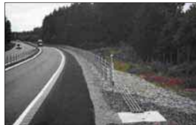
شکل ۶- مهار کابل در End Anchor
