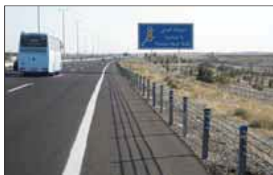
شکل ۲ - حفاظ کابلی اجراشده در بزرگراه تهران - قم
