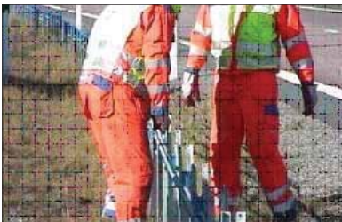
شکل ۸- تعمیر حفاظ کابلی
