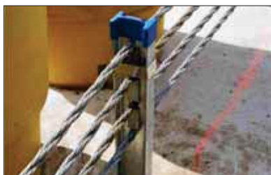
شکل ۵- اتصال کابل به پایه‌ها
