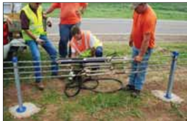
شکل ۷- تنظیم کشش کابل با استفاده از Rigging Screw
