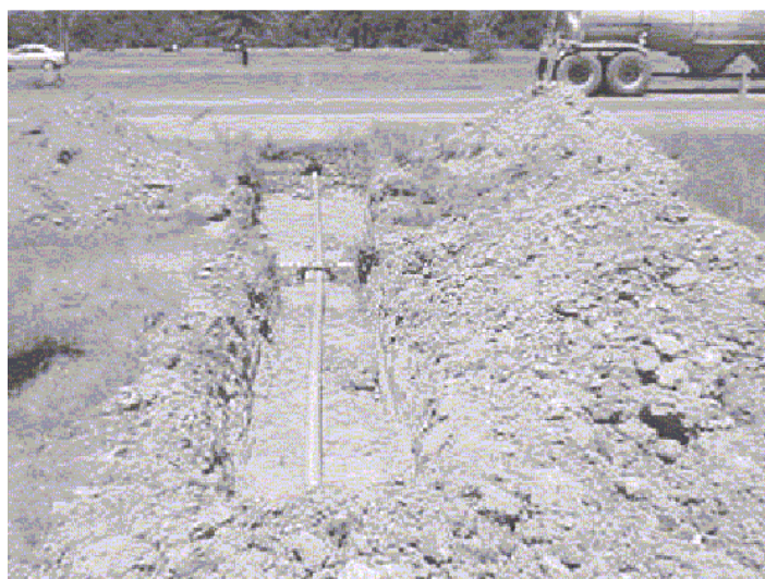
شکل ۳-۶ کانال نصب ریزحلقه‌های 3M
