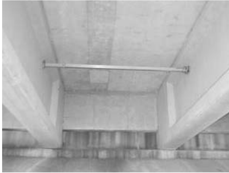
شکل ۳-۷ محل نصب ریزحلقه زیر پل FM60
